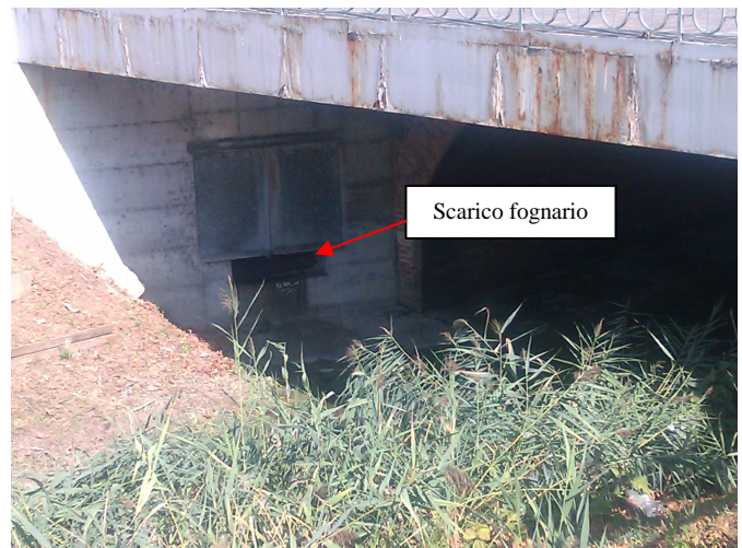
Foto 6 Particolare scarico fognario ponte Ghironda Via Emilia visto da lato monte.
