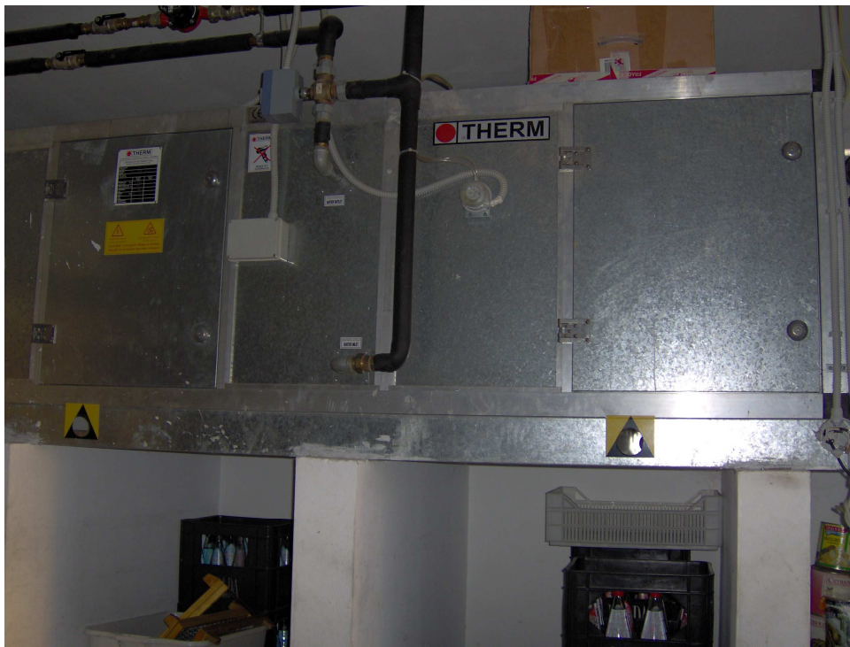
Foto 11 La macchina dell'impianto d'aerazione
