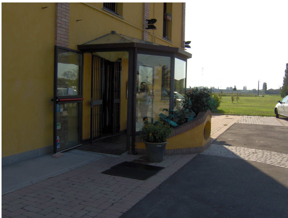
Foto 5 L'entrata sul fronte Nord-Ovest
