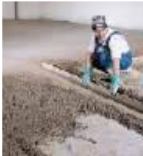
Tiro della malta eseguita a mano
