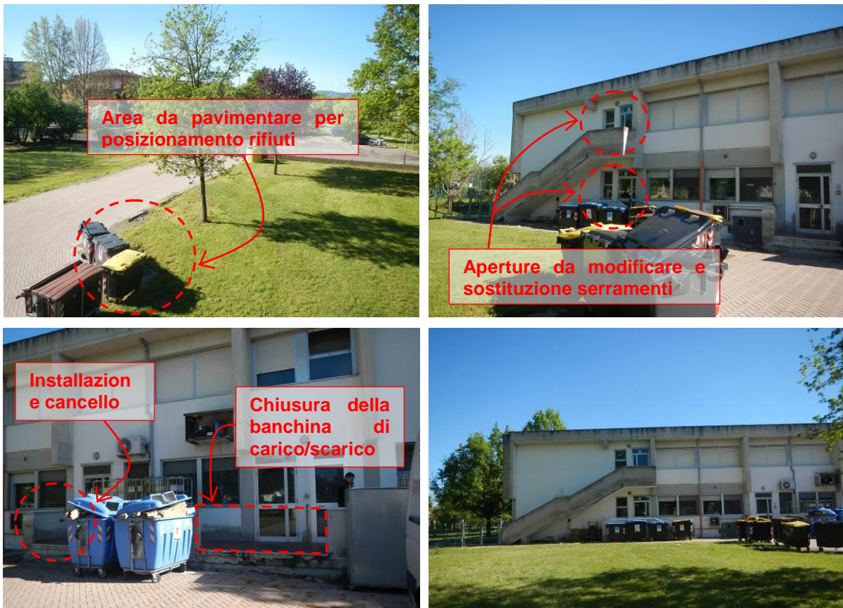
Foto esterne dello stato di fatto
