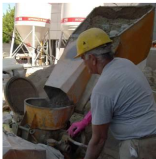
Fase di miscelazione sabbia – acqua – cemento.
