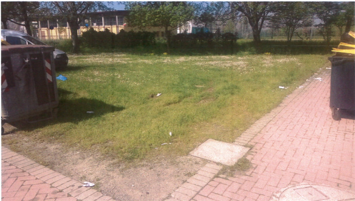
Area esterna da pavimentare in auto bloccante
