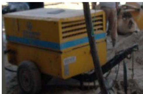
Compressore per il trasporto della malta in quota
