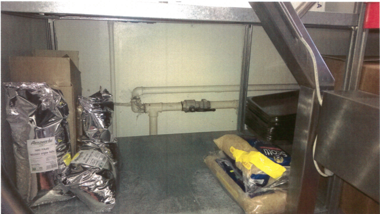
Tubazioni da coprire con controparete in cartongesso e rendere ispezionabili
