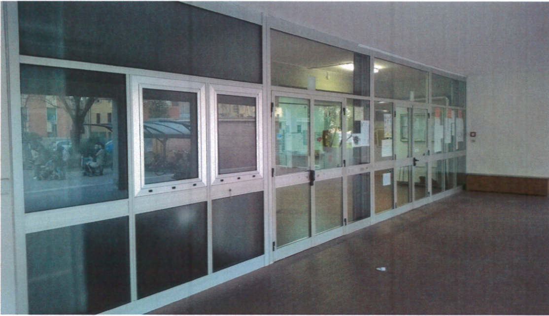
Infissi esterni nell'ingresso principale
