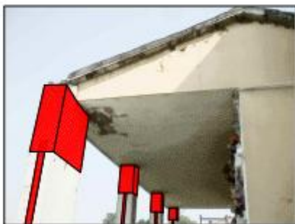
COLONNE CON RINFORZO IN FIBRA DI CARBONIO Lato Loculi zona ingresso
