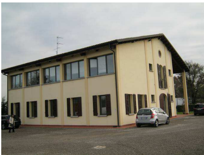
FOTO 1 Edificio Principale ad uso Uffici
