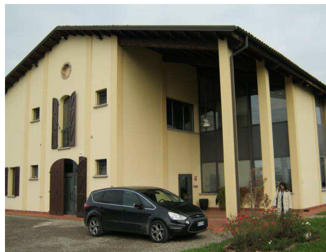
FOTO 2 Edificio principale ad uso Uffici
