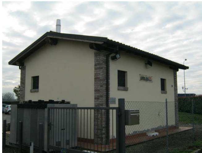
Foto 4 Edificio Accessorio ad uso CT
