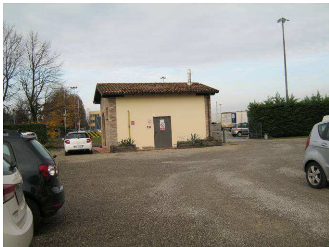
FOTO 3 Edificio Accessorio ad uso CT
