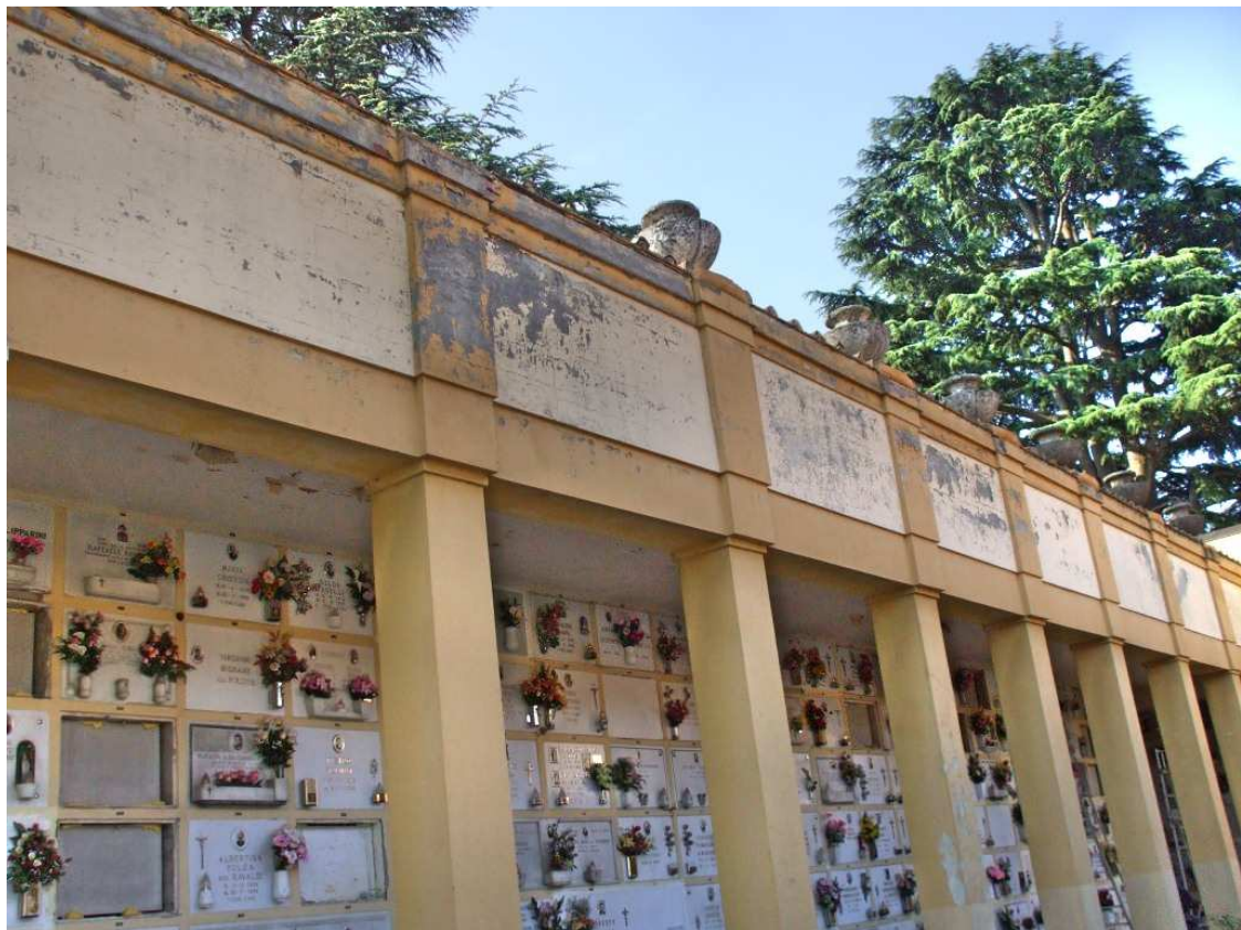
PORTICATO INTERNO A DX DELL'INGRESSO DAL PARCHEGGIO
